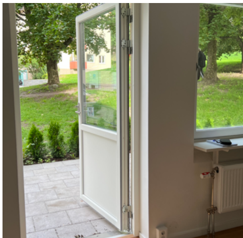
Uteplats till en av de ombyggda lägenheterna.
